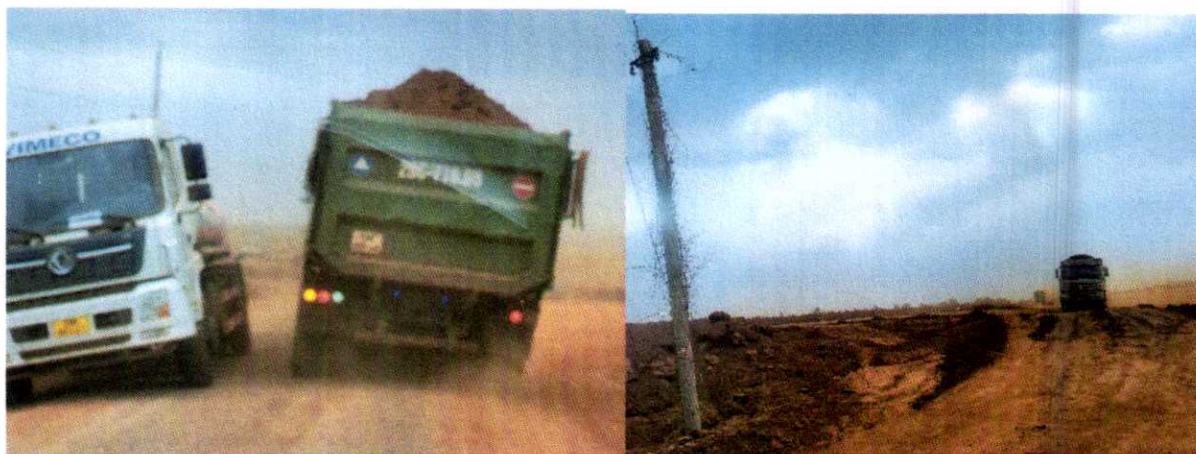
Hình ảnh xe chuyên dụng vận chuyển đất san lấp mặt bằng tại sân bay quốc tế Long Thành giai đoạn 1
